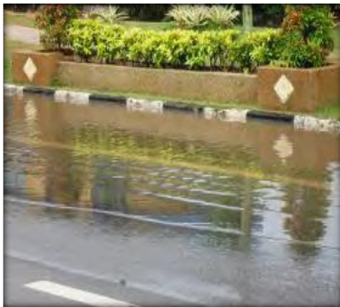
Rajah 3. Air yang bertakung disebabkan oleh erong salir yang tersumbat.
