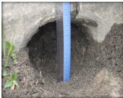
Rajah 10. Lubang Erong Salir yang telah dikorek dengan menggunakan mesin Sde
