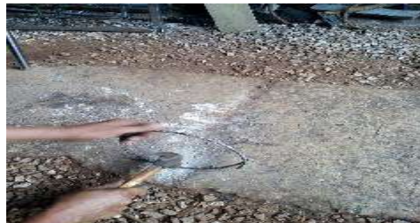
Rajah 10. Peringkat pemasangan jaring
