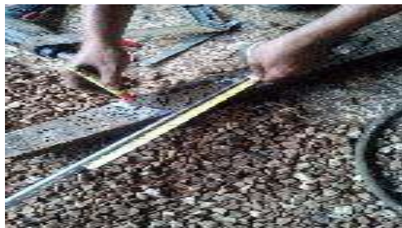
Rajah 3. Kaedah menanda besi untuk dipotong
